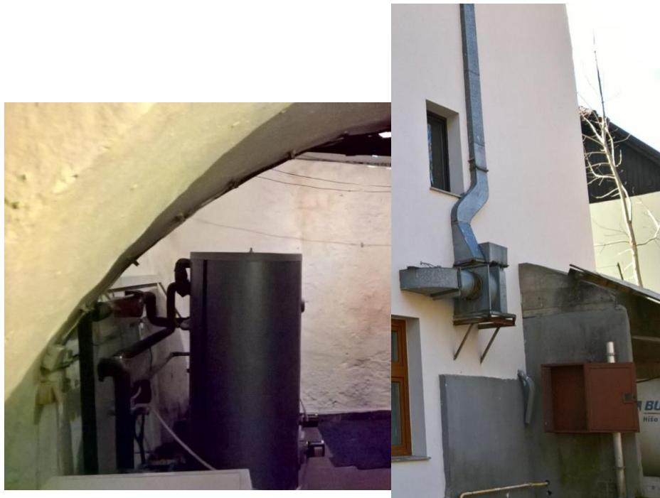
Grejanje objekta i snabdevanje topлом vodom su rešeni sistemom centralnog grejanja iz kotlarnice koja je smeštena u suterenu objekta. Zbog dotrajalosti sistema za grejanje, kao i naloge sanitarnog inspektora za zamenu bojlera za toplu vodu, proteklih godina je rekonstruisan deo mašinskih instalacija:
