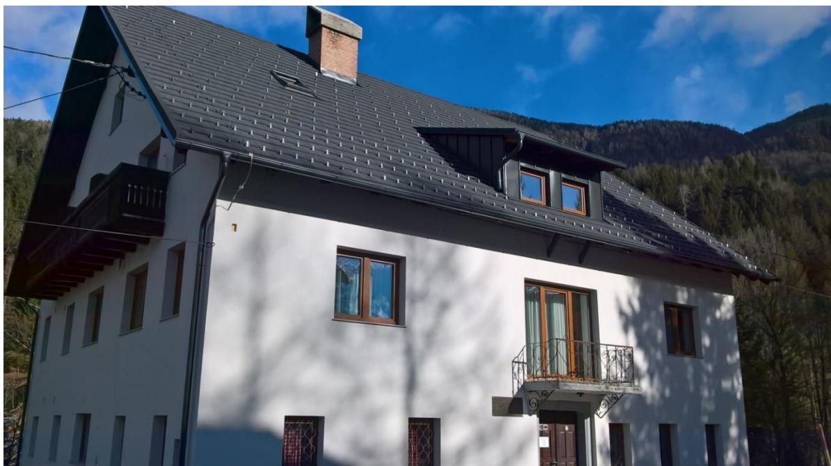
Fasada objekta je sistema "Demit" fasade, od stiropora d=10cm. Završna obrada fasade je izvedena silikatnim slojem, granulacije 1.5mm, u beloj boji.
