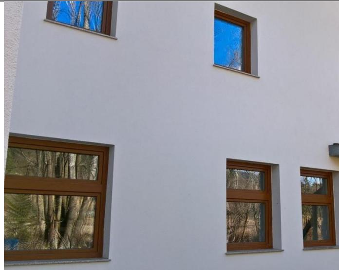
Spoljna stolarija na objektu je nova, od šestokomornih PVC troslojnih prozora i balkonskih vrata, sa koeficijentom provodljivosti  $U=0.95 \text{ W/m}^2\text{K}$ , a krovni prozori su Velux prozori. Radovi na zameni spoljne stolarije nisu u potpunosti izvedeni, tj. u prostorijama postojećih sanitarnih čvorova, predviđa se zamena prozora I balkonskih vrata sa šalukatramama, nakon adaptacije prostorija.
